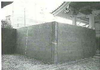
築土が完了したばかりの大練塀。壁面に木目の模様が出ている。
