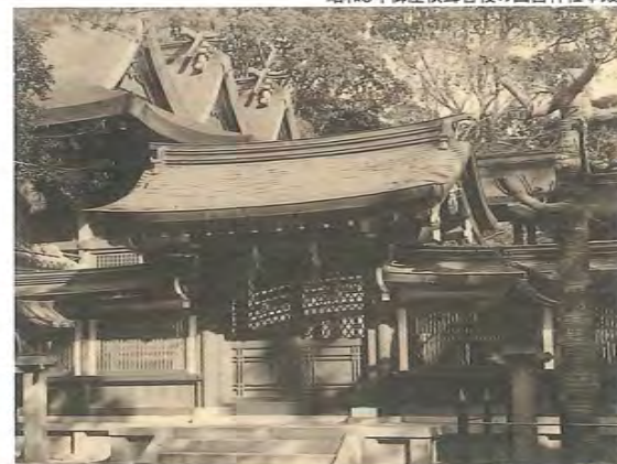
昭和9年御屋根葺替後の西宮神社本殿
